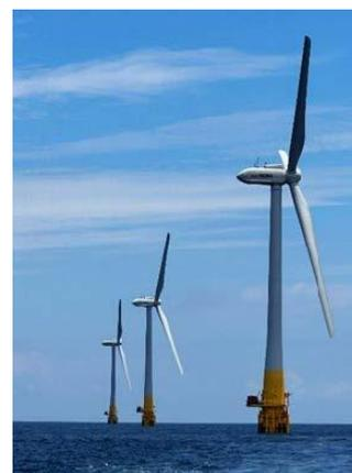
写真 1. 長崎県五島市沖の浮体式洋上風力発電施設
