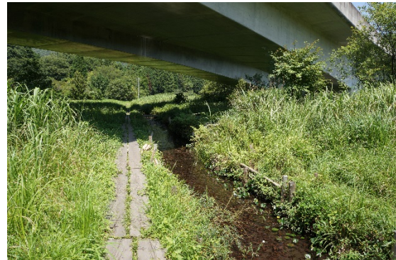
岐阜環状線高架と逆川
